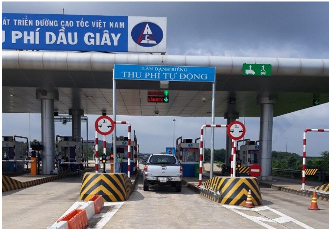
Làn thu phí tự động Trạm thu phí Dầu Giây
