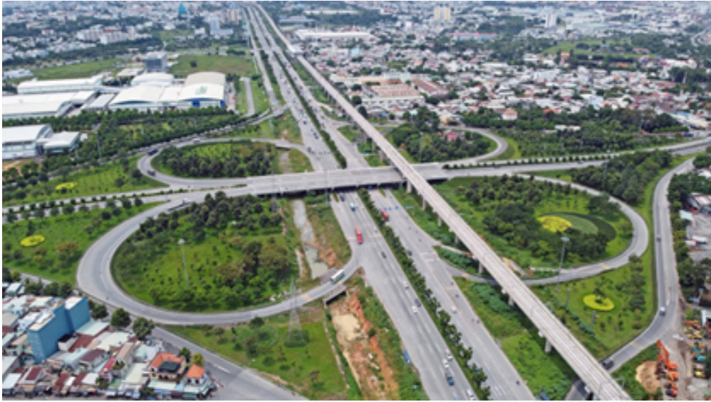
Giai đoạn 2 của đoạn Tân Vạn - Nhơn Trạch sẽ kéo đến nút giao Thủ Đức, TP HCM.
