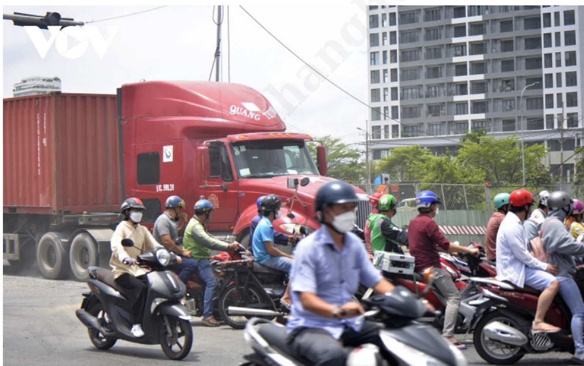
Dự án hầm chui nút giao Nguyễn Văn Linh - Nguyễn Hữu Thọ cũng đang gấp rút thi công để sớm hoàn thành (ảnh Hà Khánh)
