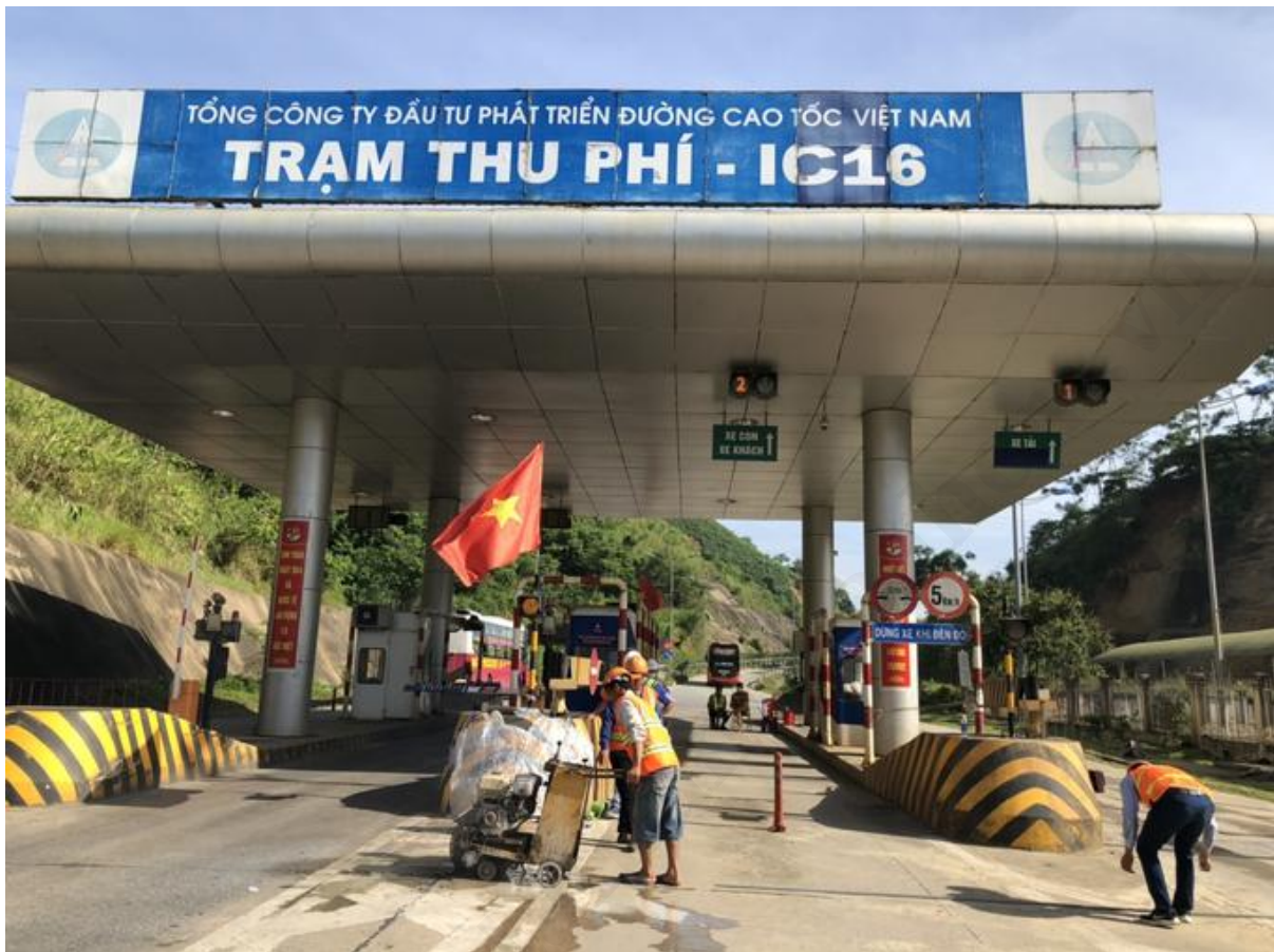
Thi công hố móng giá long môn phục vụ thu phí ETC tại trạm thu phí IC16, tuyến cao tốc Nội Bài - Lào Cai
