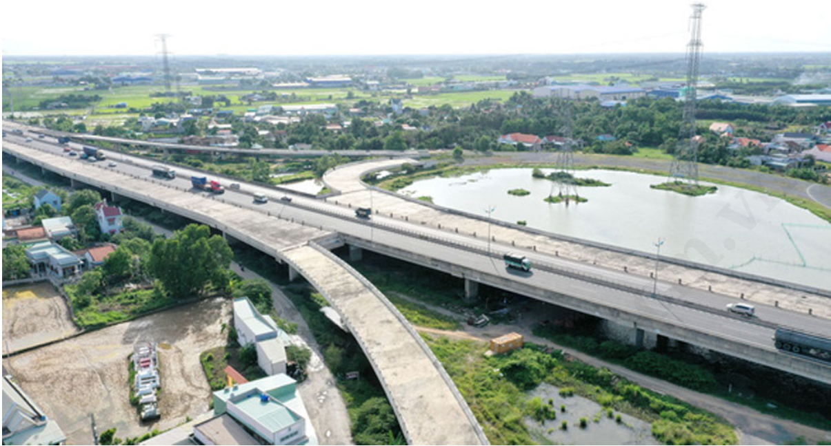
Tuyến đường vành đai 3 đi ngang khu vực xã Mỹ Yên, huyện Bến Lức, tỉnh Long An - Ảnh: TỰ TRUNG
